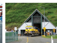
Con acceso para camiones
