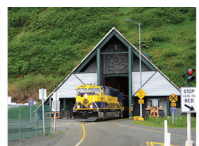
Túnel ferroviario con acceso para camiones
